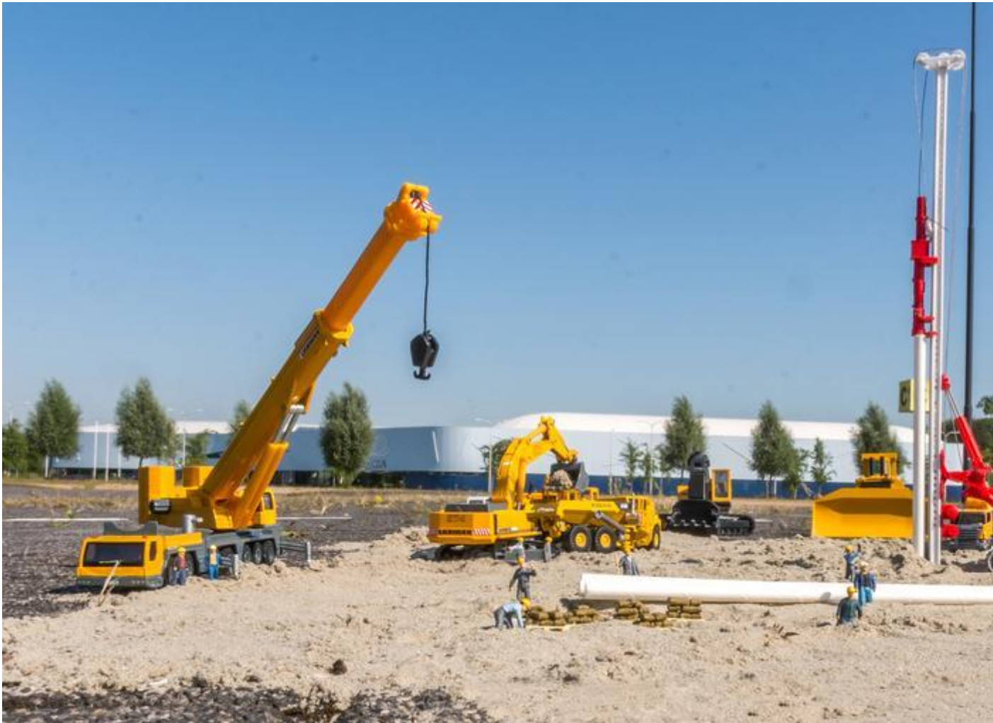
De start van de bouw van het nieuwe Cambuurstadion. FOTO MICHEL TILMA PHOTOGRAPHY
