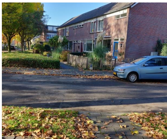
Afbeelding 7: Overliggende stoepen niet afgeschuind naar straatniveau in de Boekbinderslaan (Eigen foto, 2018).
