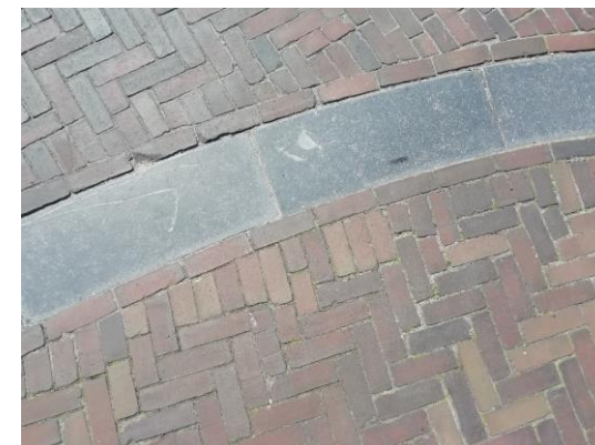
Figuur 7.9 – De bestrating en de band welke de rijloper van het trottoir scheidt (eigen foto)
