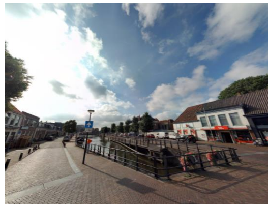
Figuur 7.6 – De Stadsgracht gaat onder de Oosterpoortsbrug door (Streetsmart, 2019)
