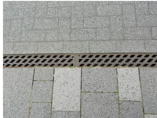
Figuur 4.12 – Lijngoot welke de rijloper van het plein scheidt (eigen foto)
