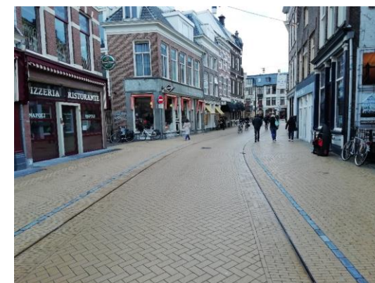
Figuur 6.9 – Overgang bestrating in het oostelijke deel (eigen foto)
