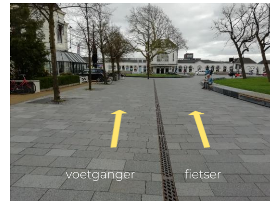
Figuur 4.16 – Lijngoot welke zorgt voor een suggestieve scheiding tussen voetgangers links en fietsers rechts (eigen foto)
