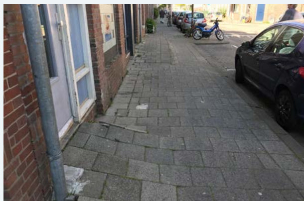
Dwars liggende helling is te steil en een struikelgevaar.
