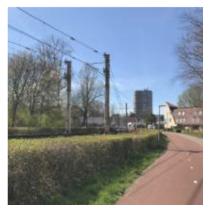
Barriere door metrolijn
